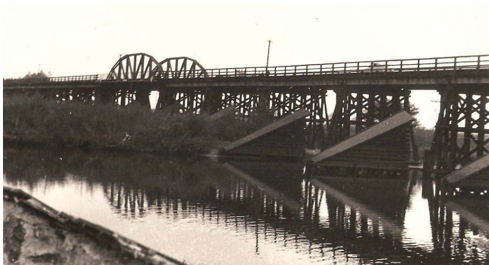
Nieistniejący drewniany most w Łądzie (WSD)
