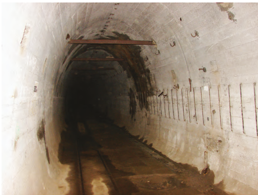
Tunel komunikacyjny – MRU – fot. A. Chmielewski
