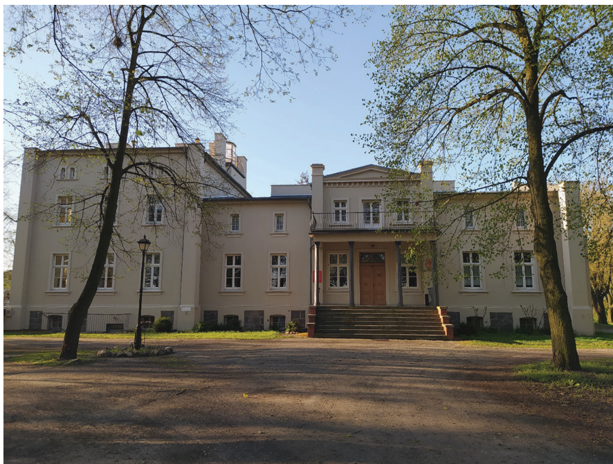
Fot. 1. Budynek Ośrodka Edukacji Przyrodniczej w Łądzie (fot. A. Kaźmierska)
